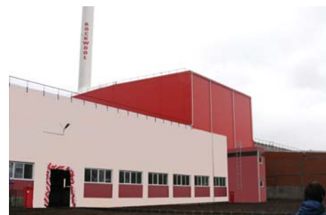
Завод Rockwool North, Выборг
